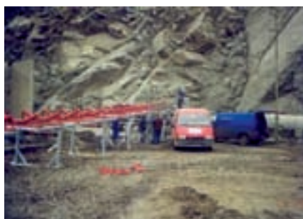
Lieferung und Montage einer Bandanlage in einem Steinbruch
