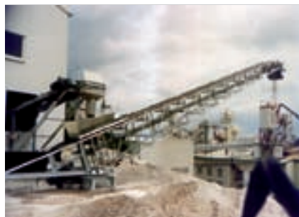
Lieferung und Montage eines Schwenkbandes mit Zuführband
