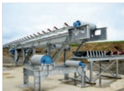
Umlenkstation einer Bandanlage im Aufbau
